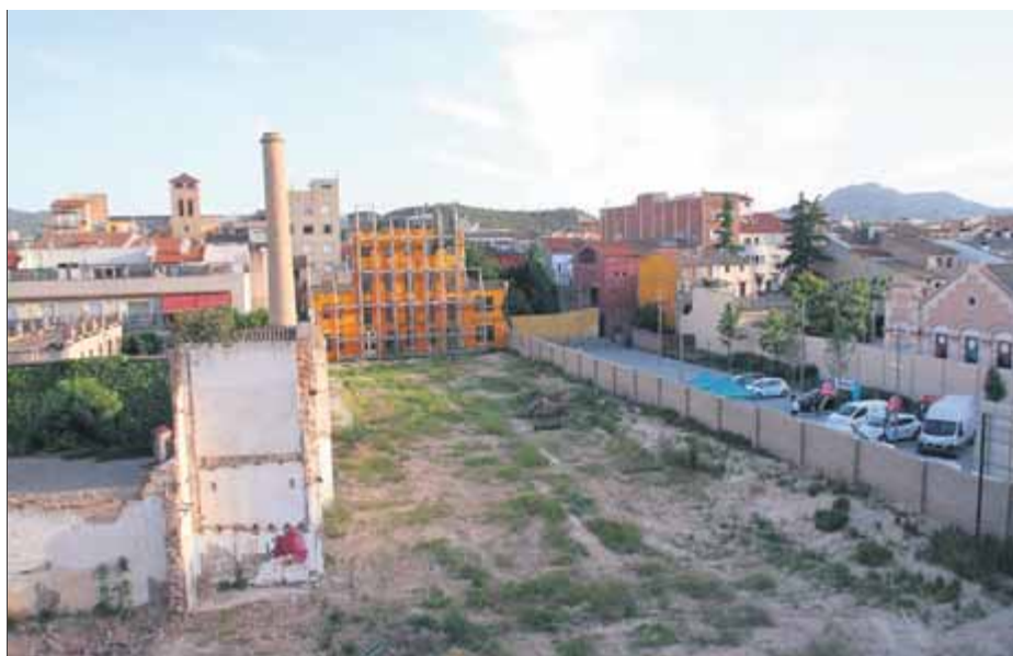
El solar a tocar de la plaça de Cal Font, on es construirà l'edifici ■ ÓSCAR LÓPEZ
